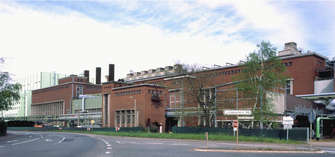
Fabrik Berrenrath. Von links: Hochdruckkraftwerk und Trockenhaus 2. Dem Trockenhaus II vorgelagert die Kohleverladung für die nach Wesseling transportierte Kohle, 1939-41.
