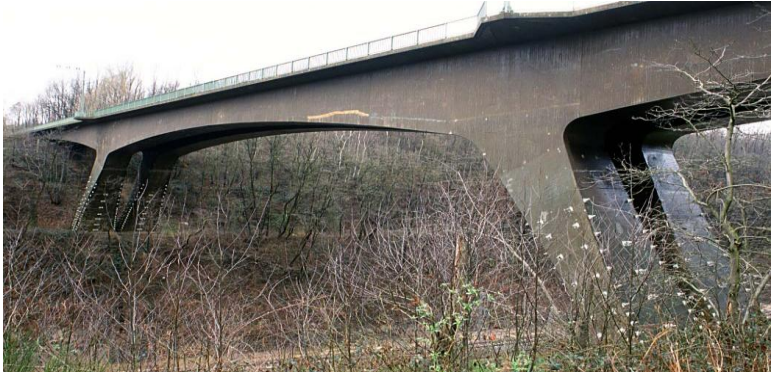
Horremer Brücke, 1953/54. Arch.: Ulrich Finsterwalder. Spannweite 64m über die Strecke Köln-Aachen. Foto: 2002 Walter Buschmann Köln
